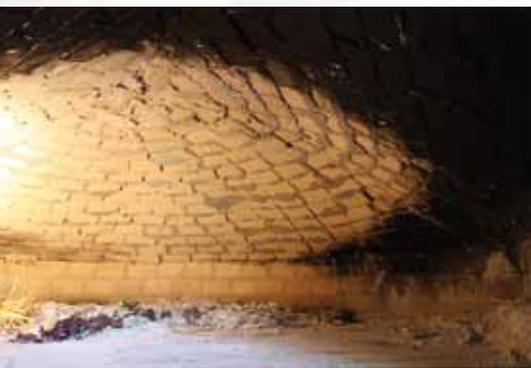
*Casa Fabrica - Montecchio. L'interno del forno, con il soffitto di mattoni posti di taglio per formare la volta a botte.*
