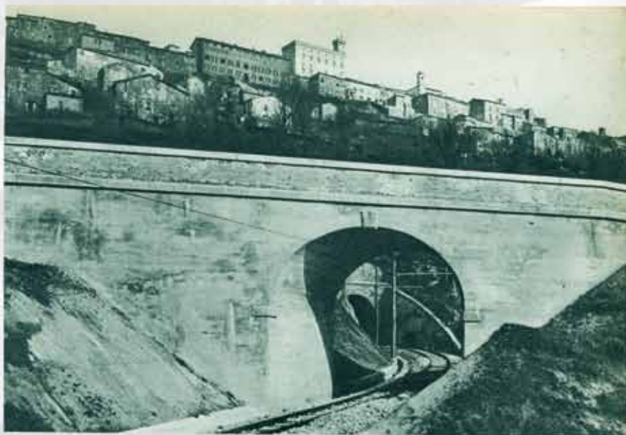
Ingresso della ferrovia sotto la Città - galleria Piagge.
